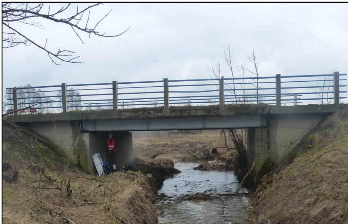
Rys. 1.2 Widok na obiekt od strony wody dolnej
